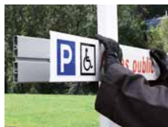
Instalar la nueva lama «Mensaje» sobre la estructura del cartel.
