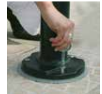
Se atornilla y se bloquea el conjunto con una llave triangular.
