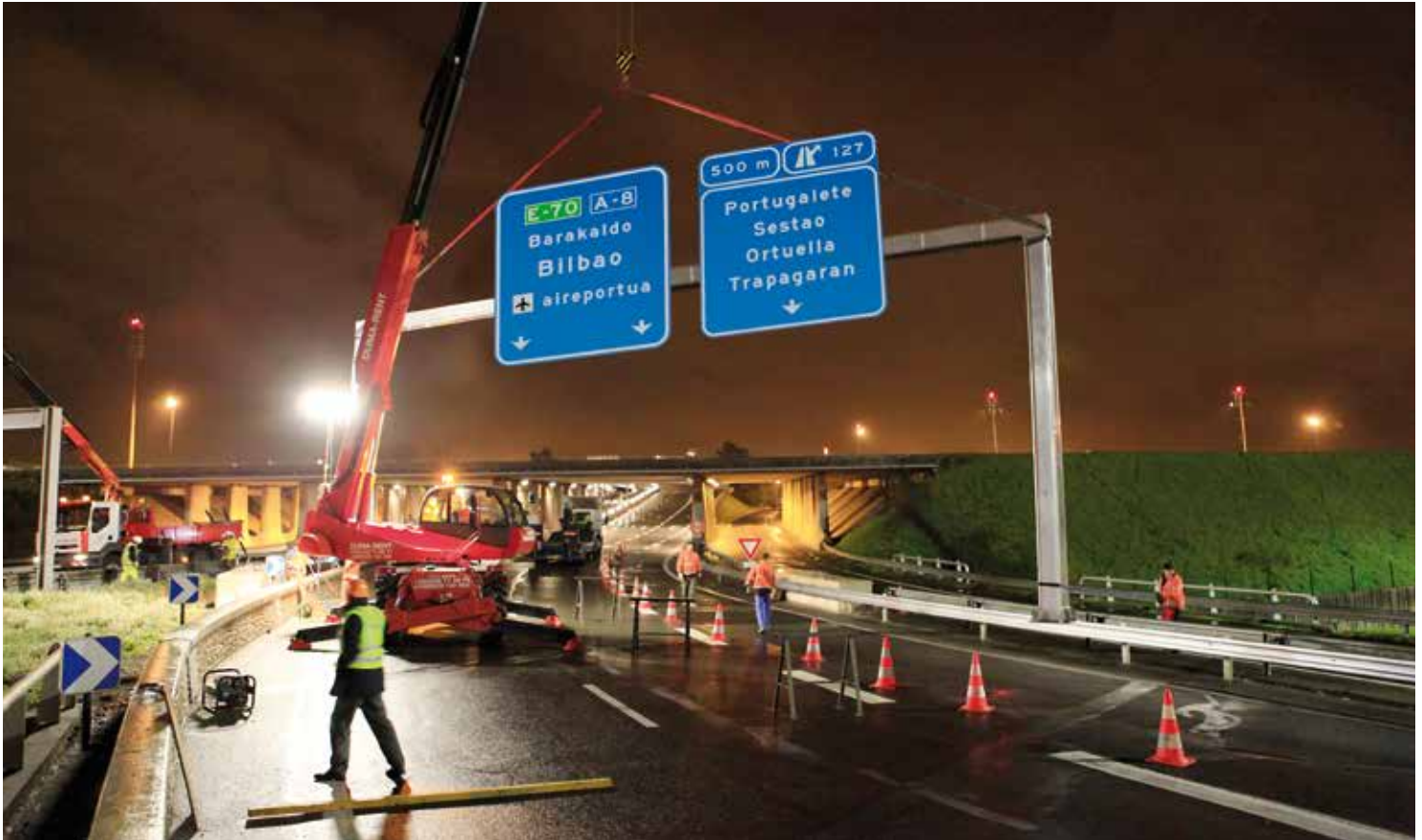
Colocación de un portico
