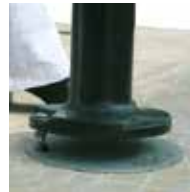
Fijación con los 2 tornillos para guiar.
